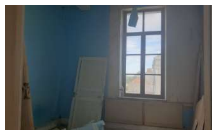
Vu d'une chambre
