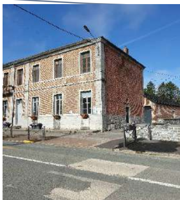
Devant le futur logement
